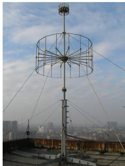
Рис.1: Пеленгаторная антенна АИК-С
