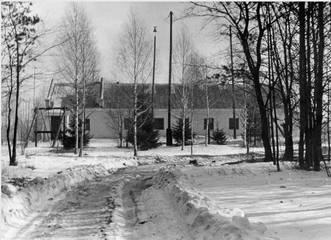
Перша технічна будівля
